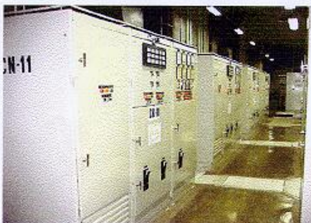
Fig. 4 - Cargador de acumuladores
